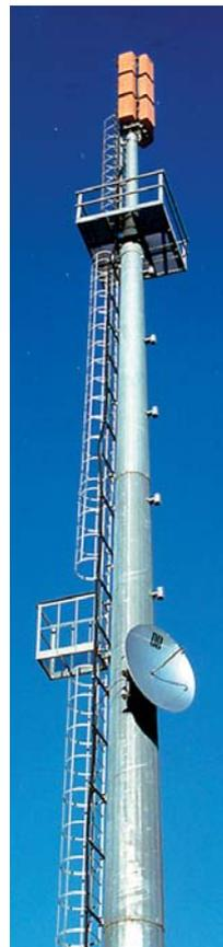
La forma particolarmente snella, la semplicità e rapidità di montaggio, nonché i costi contenuti rispetto ai sostegni a traliccio, hanno fatto sì che il palo monotubolare da lamiera trovasse largo utilizzo nel settore delle telecomunicazioni. L'esperienza maturata nelle progettazione e realizzazione di tali sostegni ci propone come fornitori qualificati fra le maggiori società italiane del settore.
